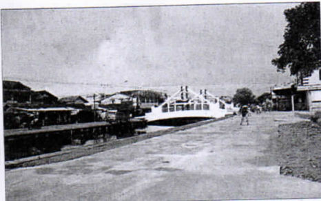
SUNGAI JAWI: Pembangunan jalan paralel Sungai Jawi terus dilakukan. Satu kawasan jalan paralel tersebut sudah terhubung. Dalam dua tahun ke depan direncanakan rampung.
