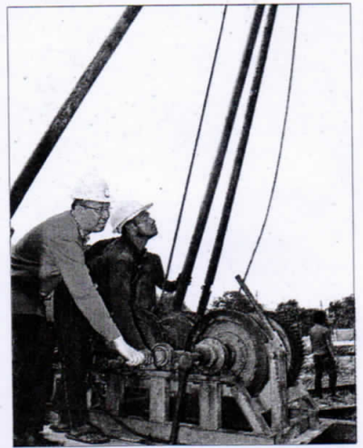
KOLAM RENANG: Pemkot Pontianak membangun kolam renang di Jalan Ujung Pandang II, Pontianak Kota. Pemanangan tiang pertama dilakukan November 2014.
