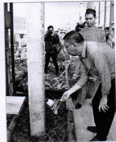
TEPUNG TAWAR: Wali Kota Sutarmidji melakukan prosesi tepung tawar pada pemancangan tiang pertama gedung rawat inap RS Sultan Mohammad Alkadrie, tahun lalu.
