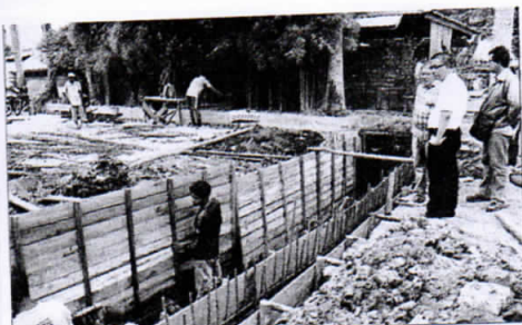
DRAINASE: Wali Kota Sutarmidji meninjau pembangunan drainase di Jalan Putri Dara Nante
