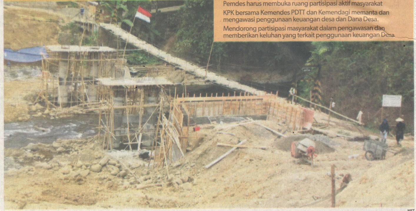
JEMBATAN DESA – Masyarakat desa membangun jembatan yang jadi sarana menghubungkan beberapa wilayah. Pembangunan ini memanfaatkan Dana Desa (DD), yang penggunaannya akan diaudit oleh Badan Pemeriksa Keuangan (BPK) pada September 2017.
