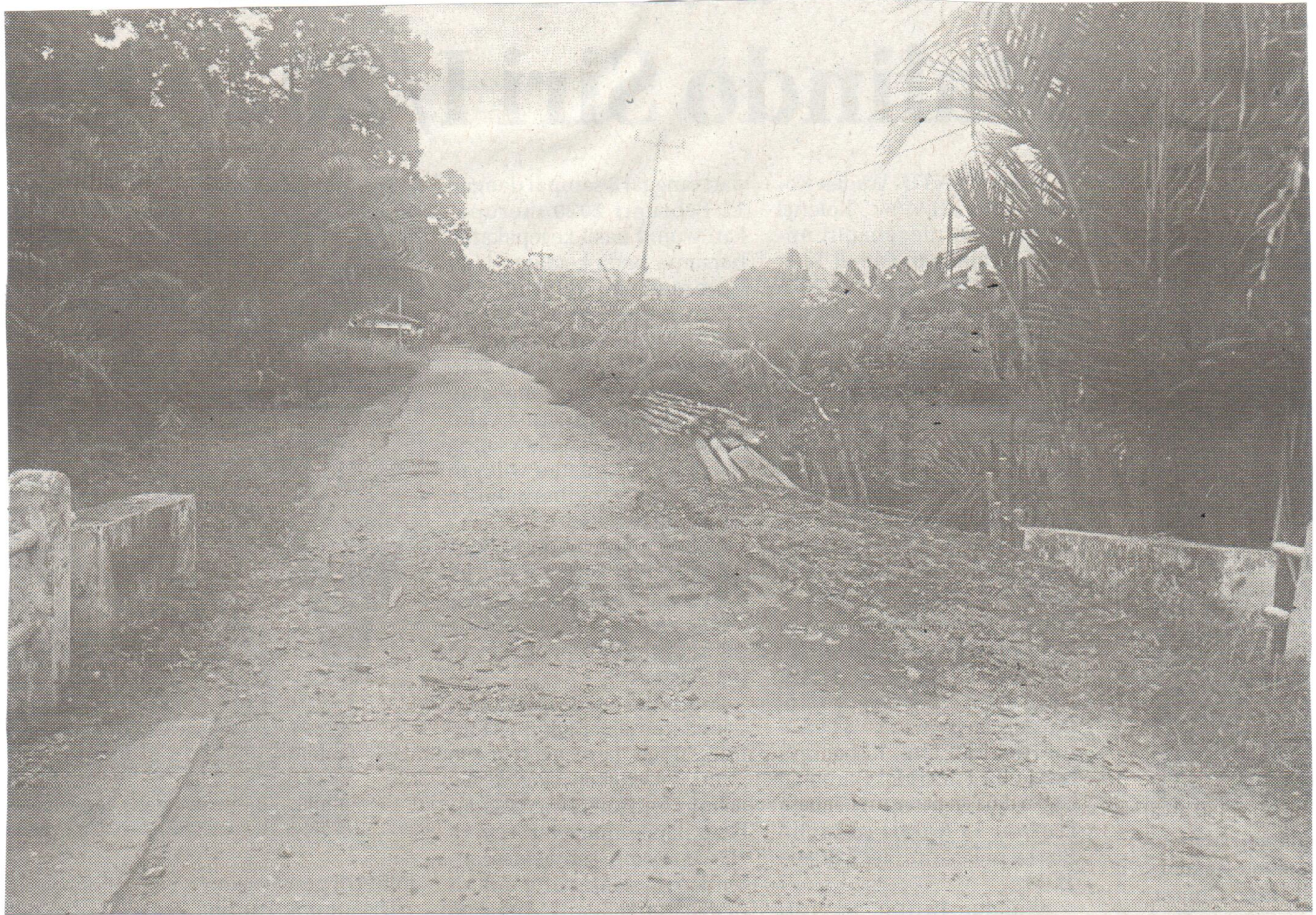
RESPON CEPAT: Kondisi ruas jalan Desa Aur Sampuk menuju Sebangki yang rusak telah diperbaiki, Selasa (11/2).
