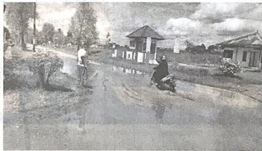
TERGENANG - Kondisi Ruas jalan arah Bandara Pangsuma Putussibau, Kecamatan Putussibau Selatan, tergenang air, Kamis (12/5).
