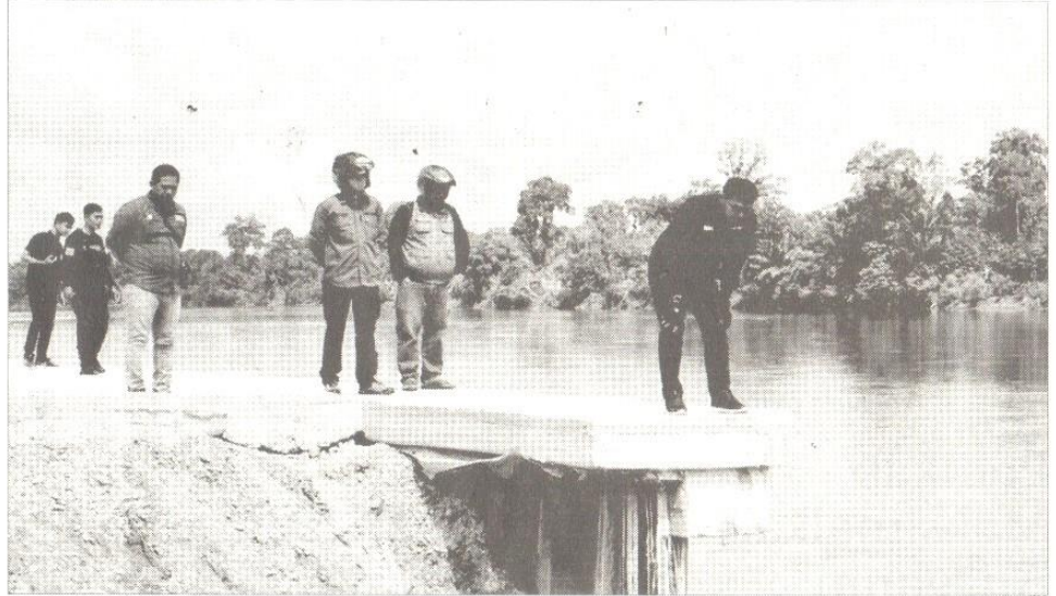
CEK: Bupati Kapuas Hulu Fransiskus Diaan saat mengecek pembangunan jalan dan jembatan yang dibangun pada tahun anggaran 2022.
