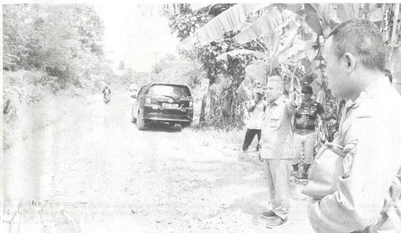
TINJAU JALAN - Bupati Kubu Raya, Muda Mahendrawan meninjau lokasi pembangunan infrastruktur jalan di Jalan Ampera, Dusun Sela, Desa Durian, Kecamatan Sungai Ambawang, Senin (13/2).
