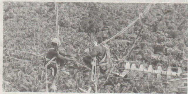
PENGERJAAN PROYEK – Petugas PLN melakukan pengerjaan pembangunan Gardu Induk (GI) 150 kV dan Saluran Udara Tegangan Tinggi (SUTT) 150 kV interkoneksi Kalimantan Barat Kalimantan Tengah dan Kalimantan Selatan.
